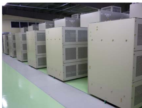
4.5MVA 交直変換装置
