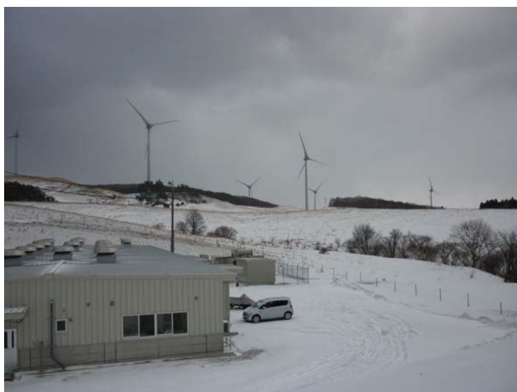
風力発電機 (15.44MW) と蓄電池室の風景 (2010年2月)
